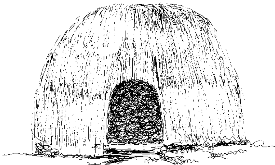
نوع مسکن روستائی خاص منطقه جبرفت مصالح ساختمانی- از نوع گیاهی بنام کل Col که در باتلاقهای هلیل رود میروید پی و سقف هردو از کل Col است
