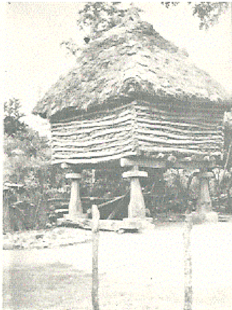
گندوج - وسیله‌ای که شلتوک را در آن انبار میکنند و درینای آن مسئله گریز از رطوبت و حیوانات خا کزی چون موش مؤثر بوده است .
